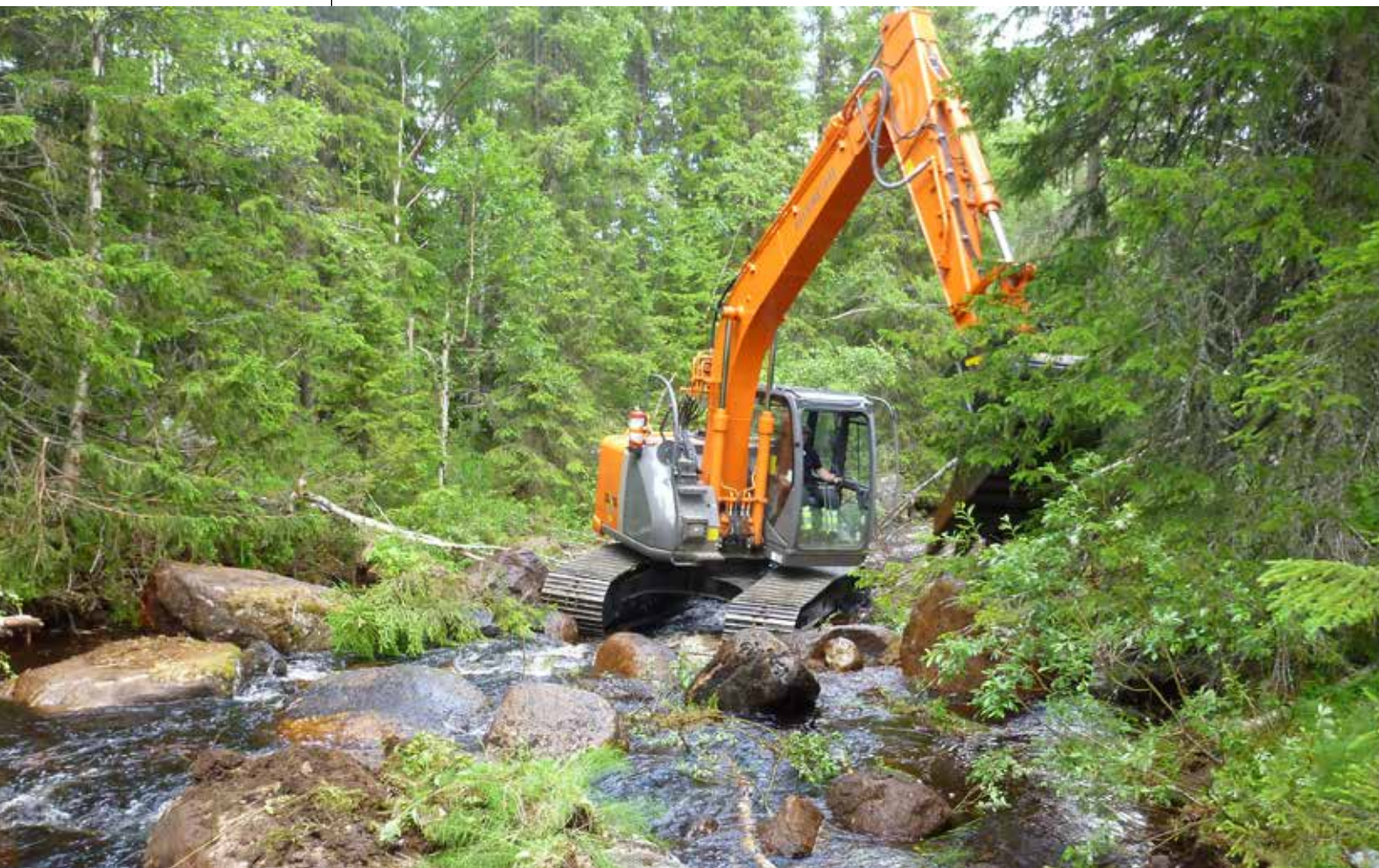
Timmerflottning krävde fria vattendrag för att stockar inte skulle fastna. Därför togs större stenar upp, vilket försämrade dessa biotoper avsevärt. Ofta lades stenbumlingarna i direkt anslutning till vattendragen, där de oftast också ligger kvar. Här ser vi hur material återförs till fåran för att återställa miljön. Foto: Länsstyrelsen Jämtland
