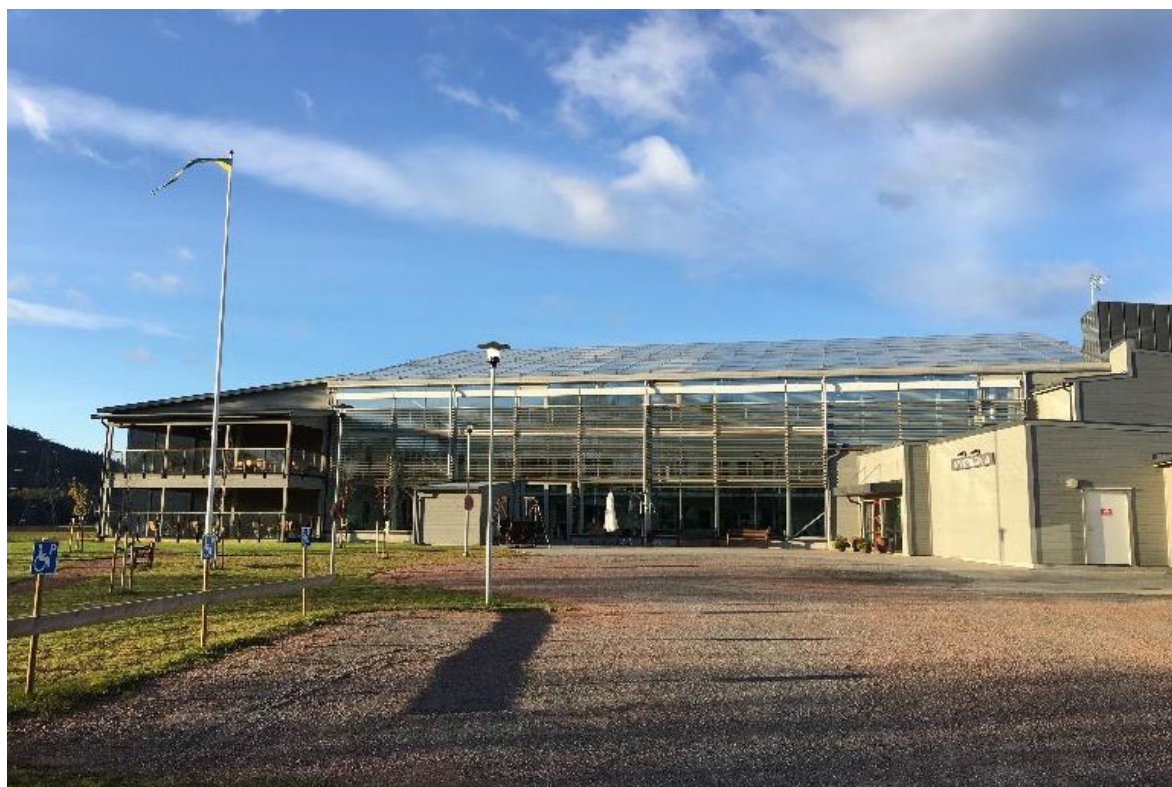
Äldreboendet Nyviksvägen i Hammarstrand.
