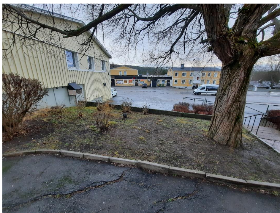
Den stora pilen stjäl näring och dess rötter har påverkat asfalten.
